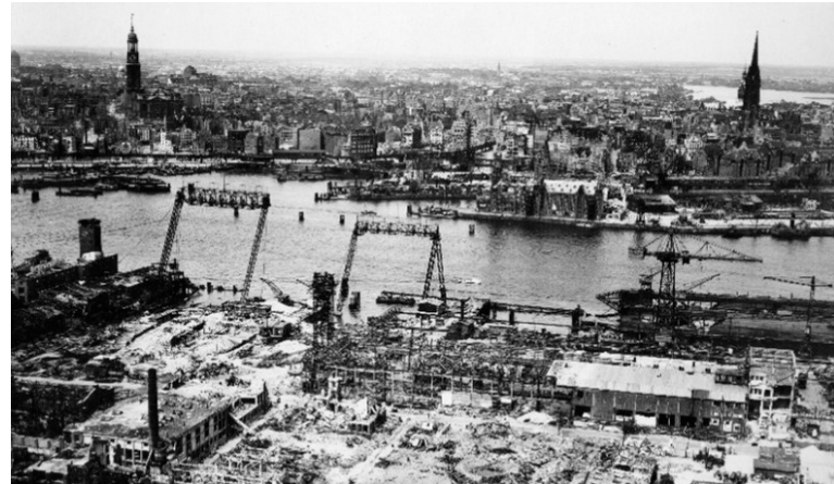
Historisches Luftbild der Zerstörungen im Hamburger Hafengebiet. Auch heute noch werden solche Fotos ausgewertet, um neue Erkenntnisse für die Kampfmittelräumung zu gewinnen.
